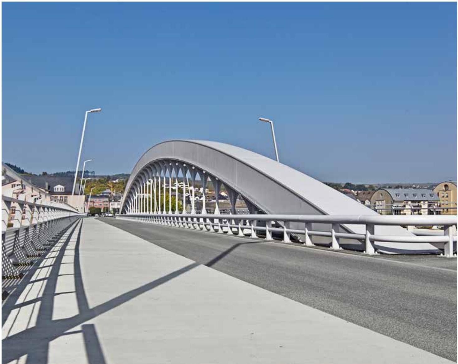
De geometrie van de constructie is zo dat de hoofdtravee zelfdragend is, wat van het grootste belang was om het transport mogelijk te maken. Deze hoofdtravee werd inderdaad vervaardigd in de haven van Mertert, om vervolgens getransporteerd te worden op de Moezel tot aan zijn eindpositie in Grevenmacher. Het dwars op de kade schuiven op platte schuiten, de goederenbehandeling van deze 1.400 ton en de installatie ter plaatse, vormden een belangrijke uitdaging voor de aannemer.
