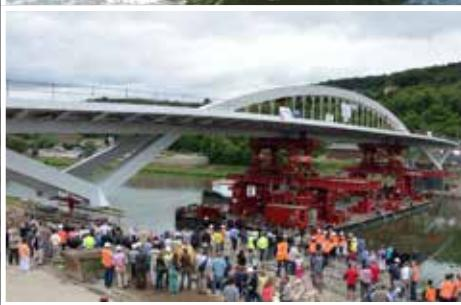
De nieuwe brug is een metalen brug met vier travéeën, met een totale lengte van 213 m. De hoofdtravée - het meesterstuk - heeft een overspanning van 113,80 m tussen de pijlers langs de oevers. De breedte van het brugdek varieert van 12,50 tot 16,10 m. Het totale gewicht van het bouwwerk ligt rond 2.000 ton.
